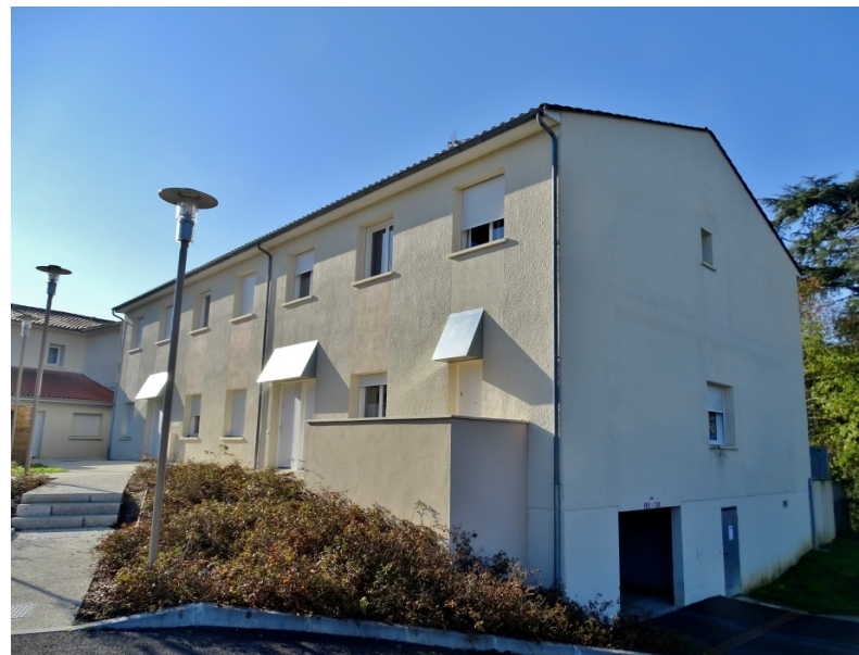
L'habitat ancien réhabilité en LLS en R+1, Chemin de Vignac
