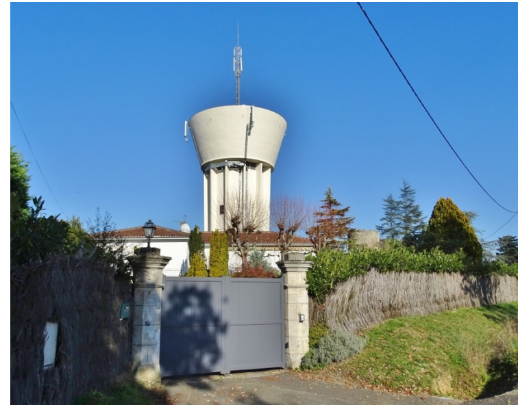
Le château d'eau du moulin de Sonney
