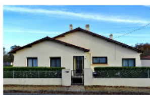
1 rue Plein ciel
