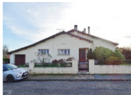
17 rue Plein ciel
