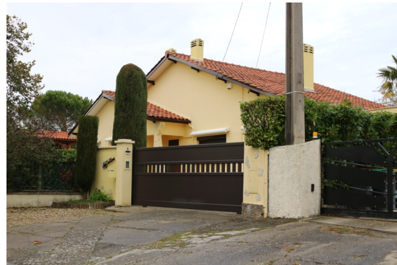
Quartier porteur d'exemple n°7: Beauséjour, Oasis
