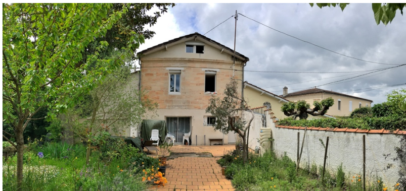
L'habitat ancien du bourg en R+1 + combles, 9 chemin des Cabiracs
