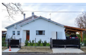
11 rue Plein ciel
