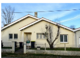
10 rue Plein ciel
