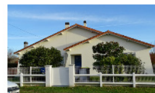
27 rue Plein ciel
