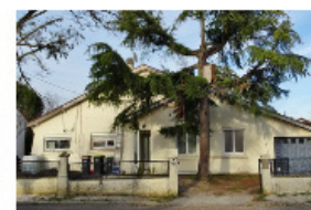
21 rue Plein ciel
