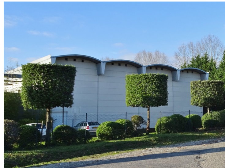
Entreprise Joanne (chaix de 12m de hauteur)
