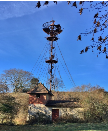
Eolienne construite par Léon Bollé à la fin du XIX e siècle – 20m de haut (Domaine du château Baritault)
