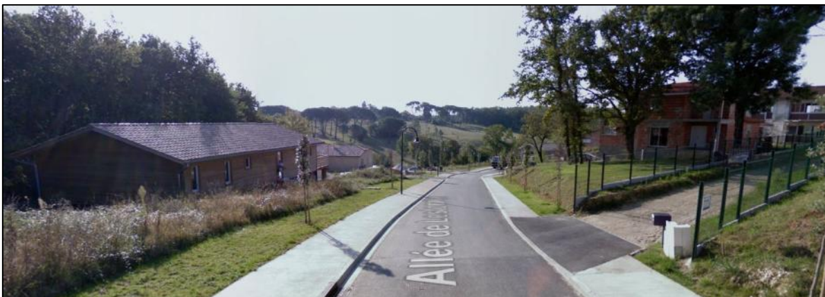
Lotissement de l'allée de Lestonnac
