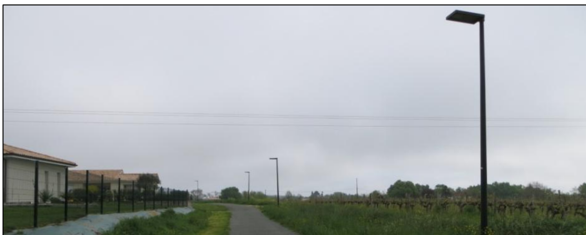
Opération nouvelle, le long du Chemin du Peyrouley, face aux vignes
