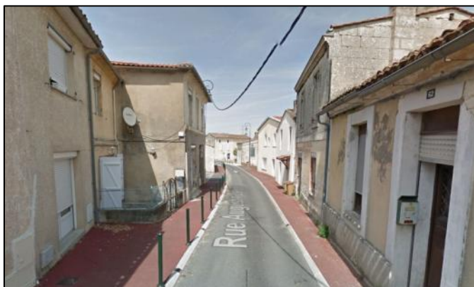
Un centre ancien relativement peu structuré et limité à une section de la Rue Augustin Daureau
