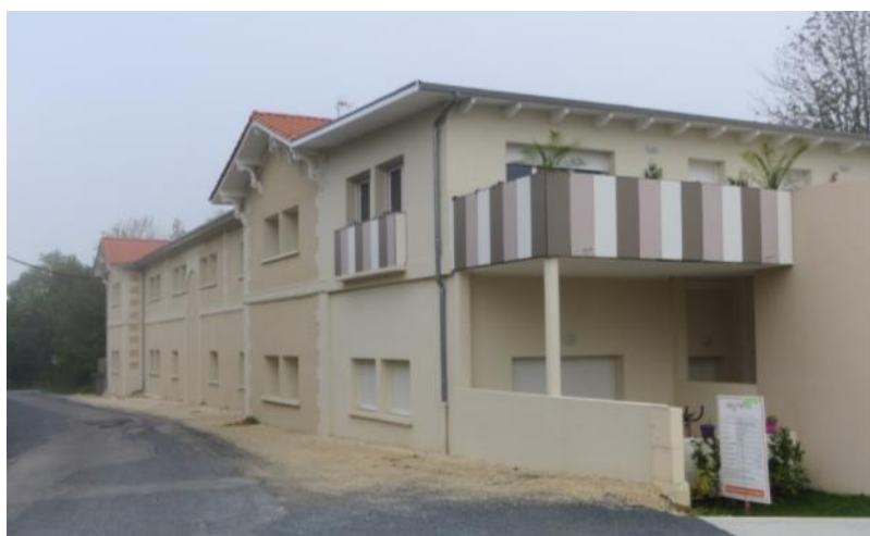
Résidence récente de logements collectifs du bailleur social AQUITANIS, sur le Chemin de Vignac (Réhabilitation d'une ancienne maison de retraite)
