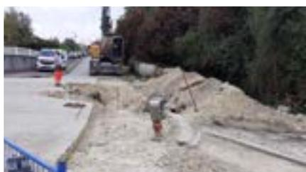
Les travaux de mise en séparatif des réseaux sur le bassin versant de Cabiracs, menée par le SIEA avancent parfaitement. Après les phases (1 et 2) de remise en état des canalisations des eaux usées et le redimensionnement du réseau des eaux pluviales sur le chemin jouxtant le foyer Jean Rivière, il reste environ 3 mois de travaux, (phase 3 et 4), pour finaliser ce chantier et permettre une mise en conformité de ce quartier et d'une
