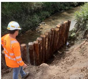
■ **Digue rive droite de la Pimpine** : La Pimpine, sur sa partie aval, est « canalisée » entre deux digues parallèles. Une encoche d'érosion ayant été constatée en décembre 2023, **des travaux de réparation ont été programmés et menés à bien.**
