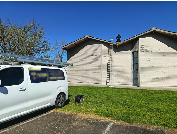
En photo, la réfection des chéneaux de L'Odyssée.
