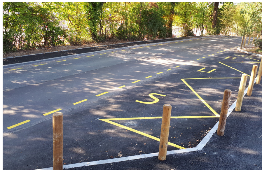
Arrêt de bus construit à Lestonnac
