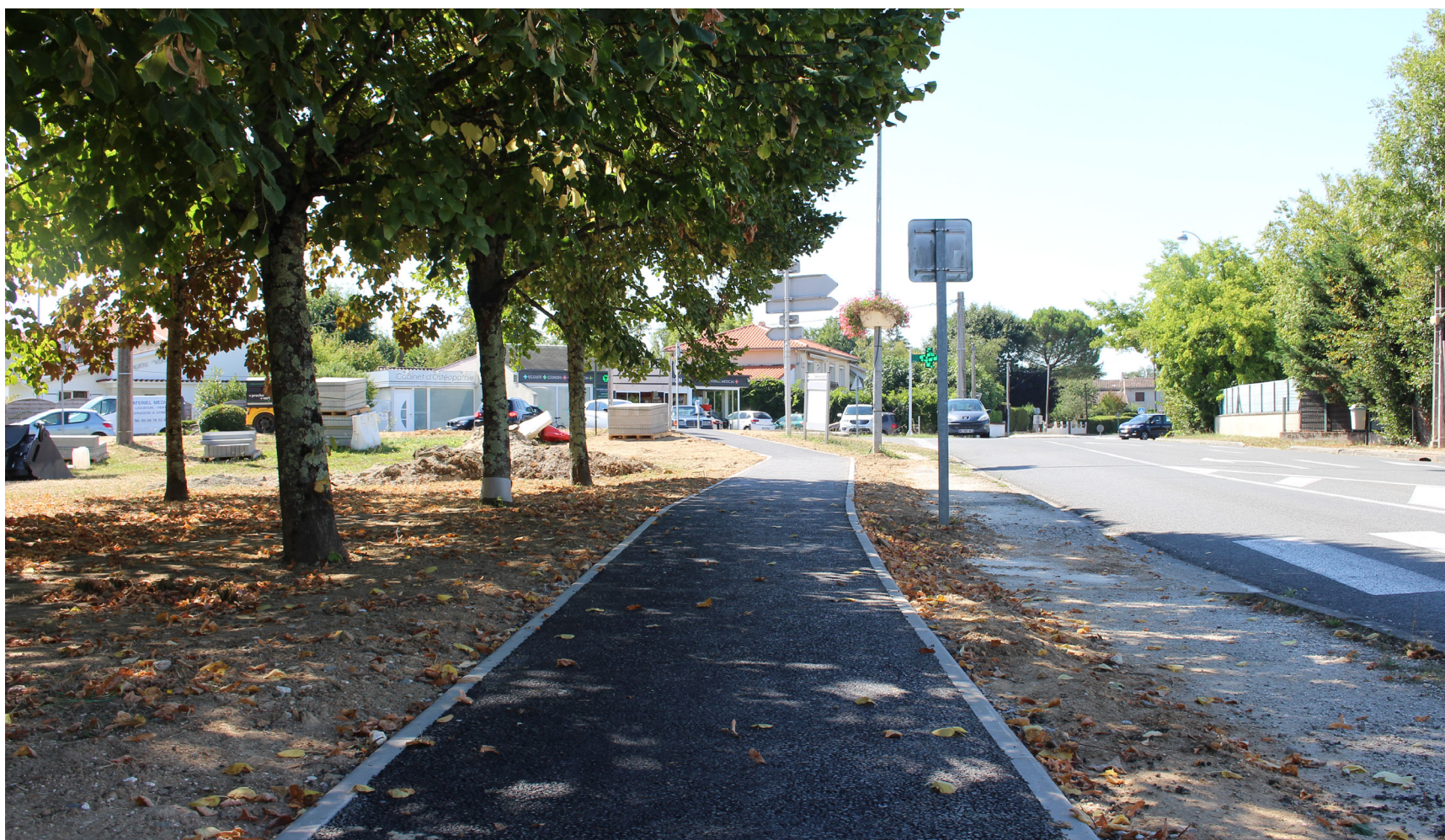
Les nouveaux trottoirs pendant les travaux, route de Tresses
