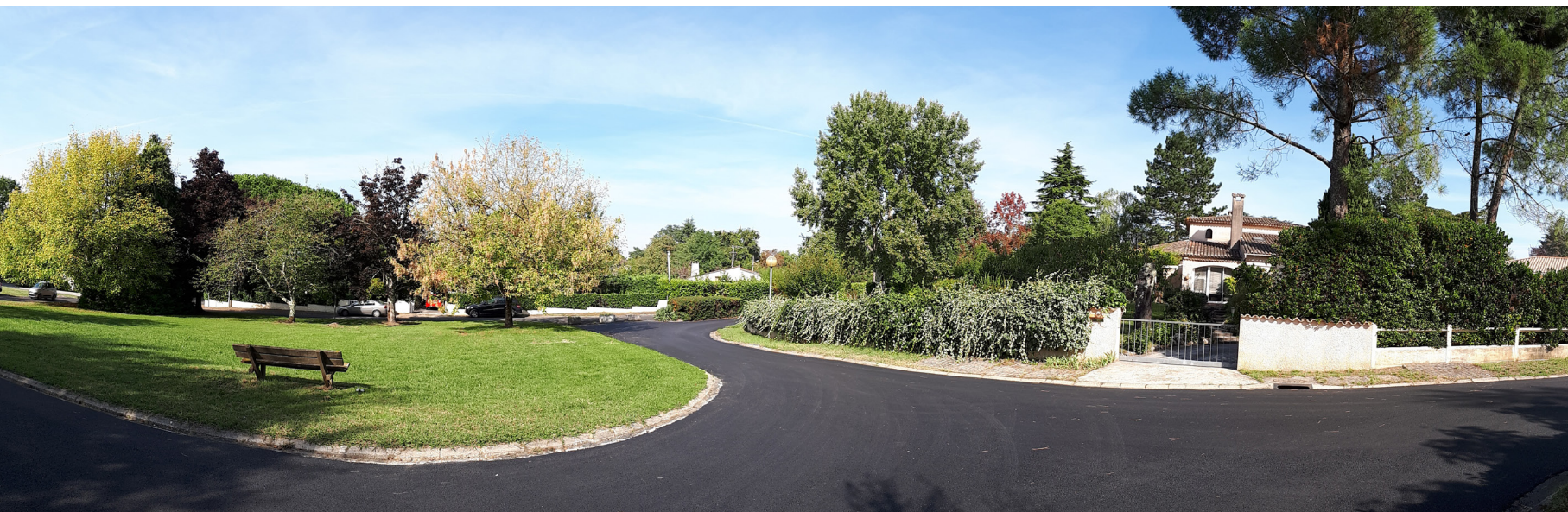
Travaux de voirie dans le lotissement Fitta
